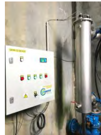
Réacteur UV du réservoir du Champet
