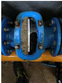
Nettoyage boîte à boue colmatée par le calcaire
