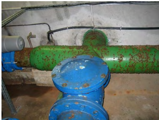
Reprise de la canalisation et des scellements
