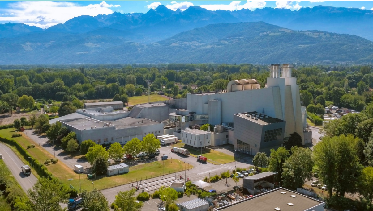
Le centre de tri et de recyclage des déchets ménagers
