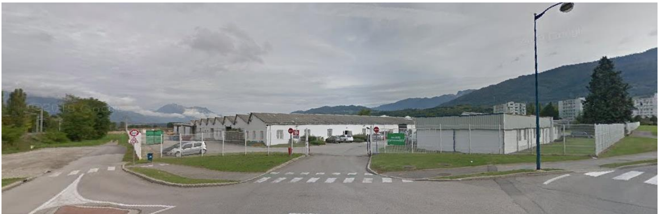
Site d'implantation du centre de lavage
