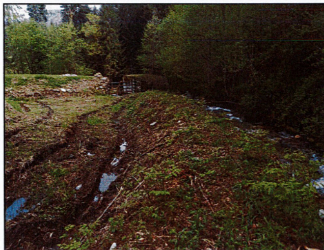
Vue vers l'aval de l'ouvrage
