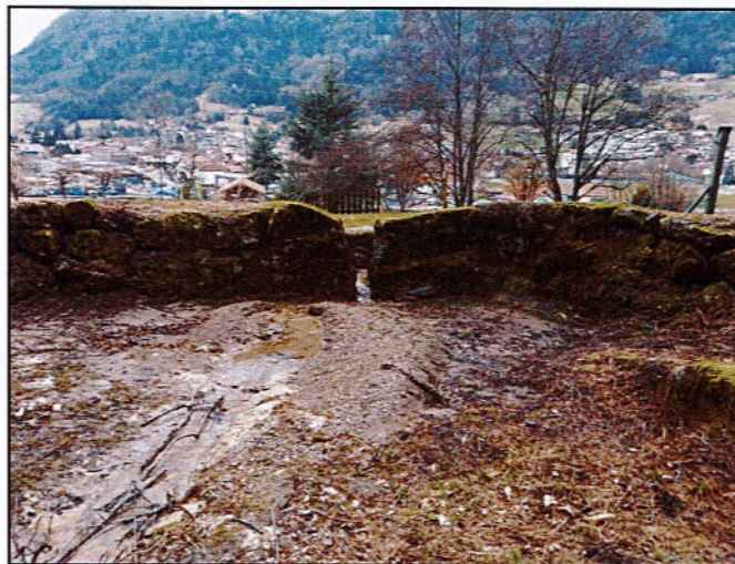
Vue vers l'aval de l'ouvrage
