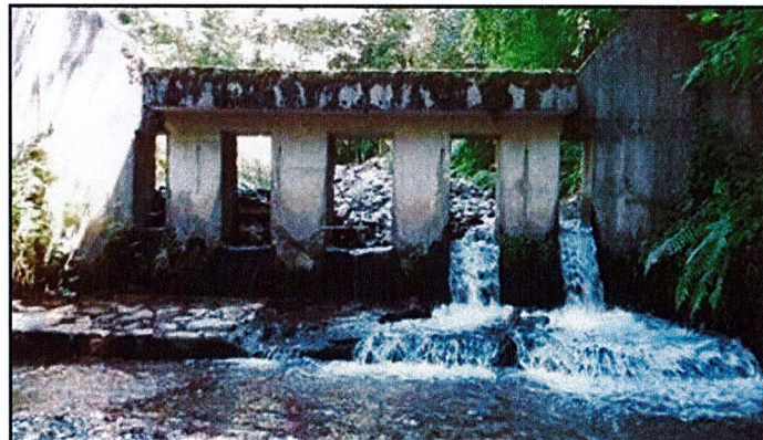
Vue vers l'amont, vers l'ouvrage de fermeture de la plage de dépôt
