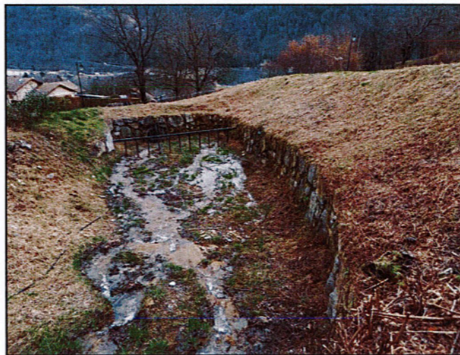
Vue vers l'aval de l'ouvrage
