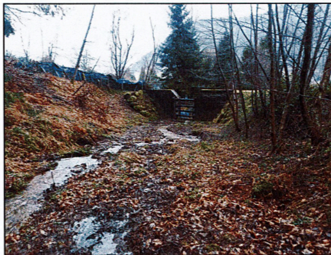
Vue vers l'aval de l'ouvrage
