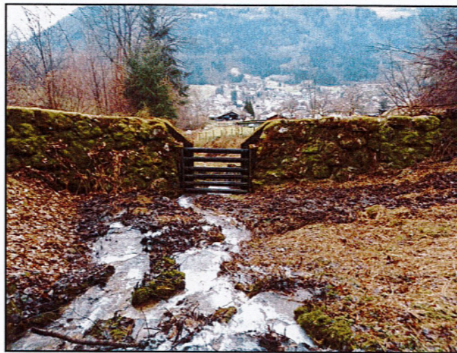
Vue vers l'aval de l'ouvrage
