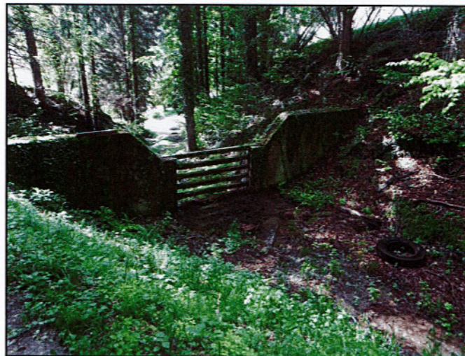
Vue vers l'aval de l'ouvrage
