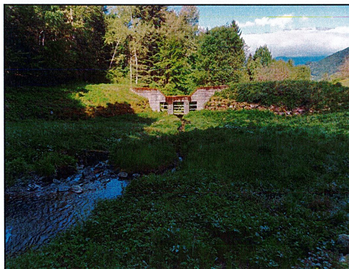
Vue vers l'aval, vers l'ouvrage de fermeture de la plage de dépôt
