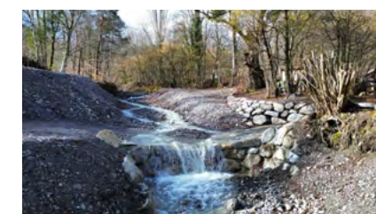
Le site après travaux
