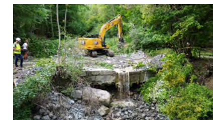
Le site au début des travaux
